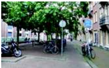
Dieser Durchstich für Radfahrer und Fußgänger verbindet in Amsterdam eine Hauptverkehrsstraße (ausgestattet mit Radweg) und ein Wohngebiet. Die bauliche Ausgestaltung und Beschilderung sorgt für Klarheit.
