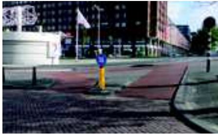
Den Haag: Aus der Nebenstraße (Position des Fotografen) kommende und in diese einfahrende Radfahrer werden auf ihrer jeweiligen Ideallinie geführt. Entlang der Hauptverkehrsstraße verläuft ein Einrichtungsradweg.
