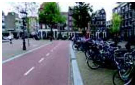
Eine klare Trennung von Fuß- und Radverkehr auf Begegnungspätzen oder in Fußgängerzonen ist in den Niederlanden Standard. Diese Lösung hat sich bewährt.
