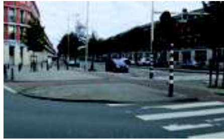
Von rechts die Hauptstraße querende Radfahrende können in Fahrtrichtung direkt geradeaus in das Wohngebiet einfahren (Den Haag).
